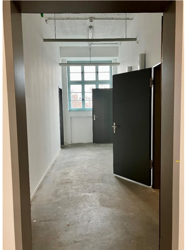
Vorraum der WCs sowie Umkleideräume
