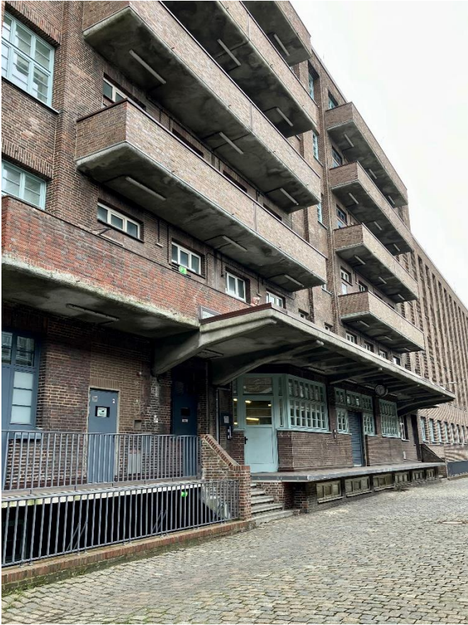
Rückansicht des Gebäudes
