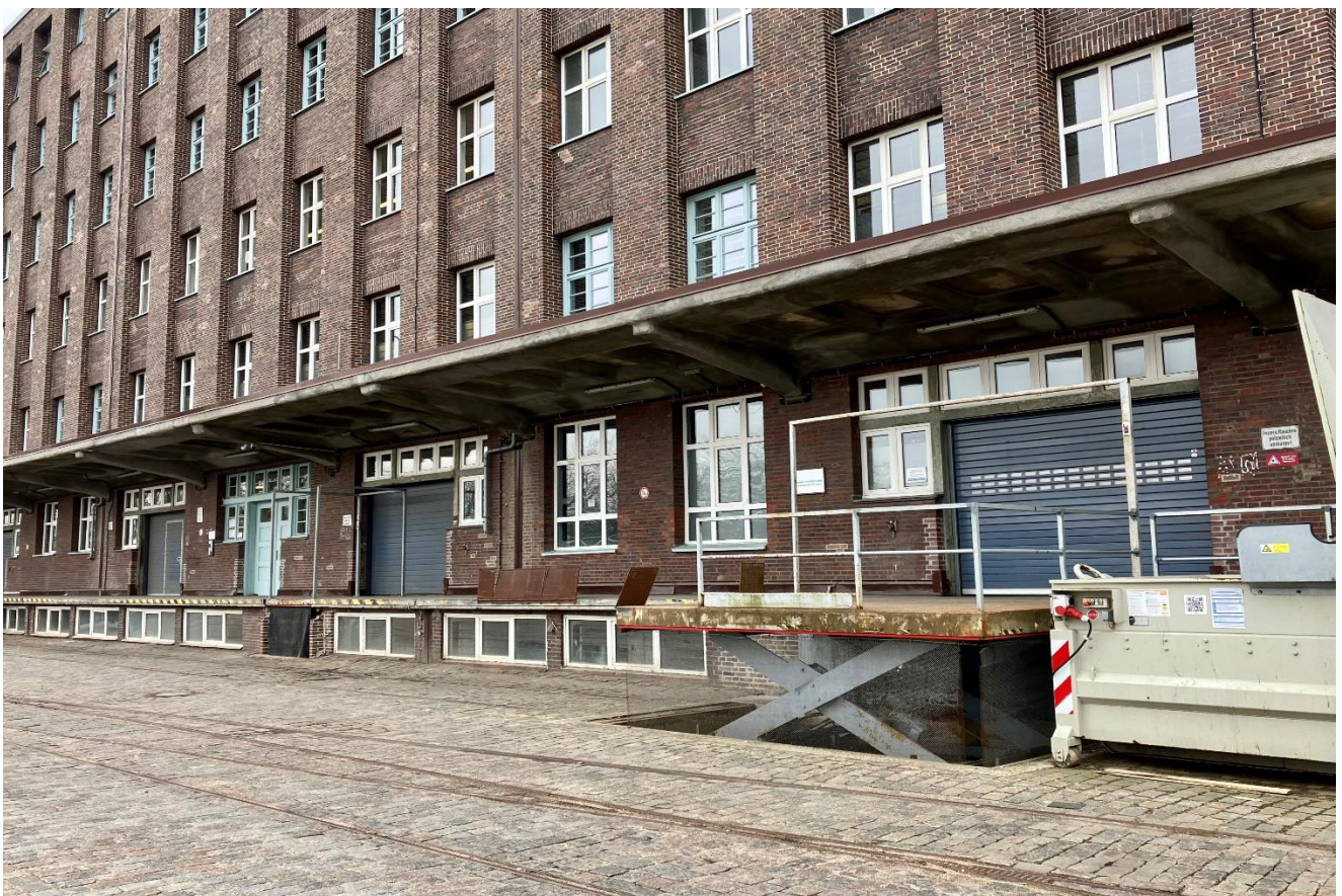
Vorderer Anlieferungsbereich mit Rampe
