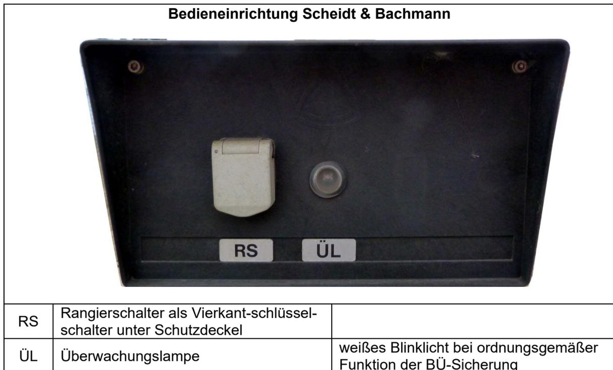
Die Vierkantschlüsselschalter werden durch das Drehen des Vierkants im Uhrzeigersinn bis zum Anschlag bedient. Für eine wirksame Bedienung ist die Stellung am Anschlag mindestens 1 Sekunde zu halten. Nach dem Loslassen kommt der Vierkantschlüsselschalter automatisch in die Grundstellung zurück.
